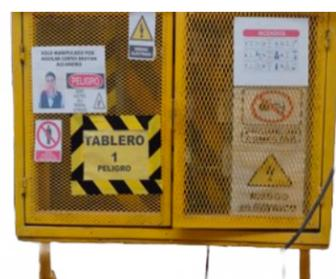
Los tableros deben ser de material **incombustible o autoextingible**, aislante, resiste a la humedad y corrosión.
